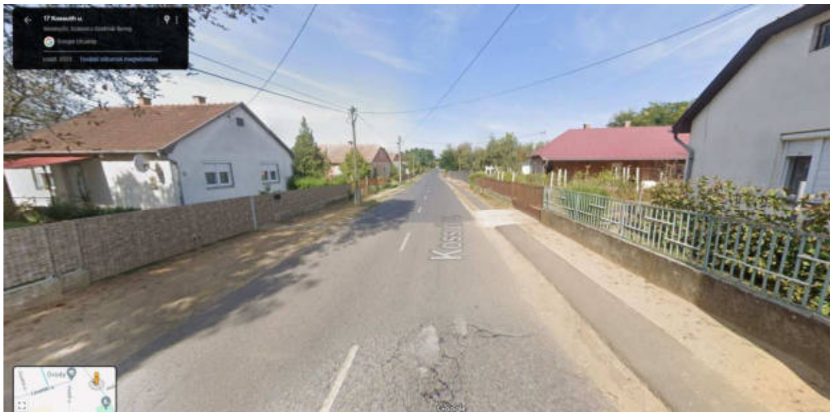
Egyoldali, aszfalt burkolatú járda a Kossuth utca mentén (forrás: maps.google.hu)
